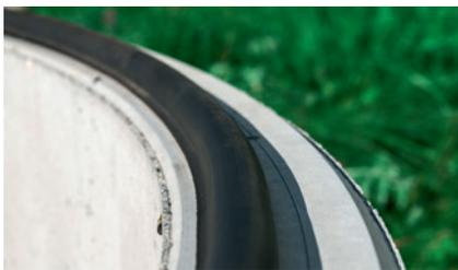
Bauteilverbinding mit verschraubter Elastomer-Dichtung
