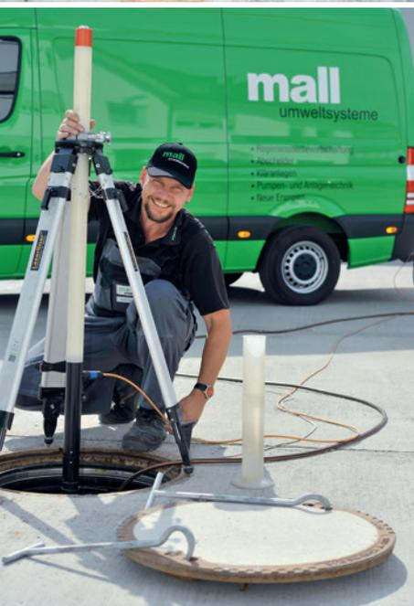
**Alle Abscheideranlagen sind vor der Inbetriebnahme und danach in regelmäßigen Abständen von maximal fünf Jahren einer Generalinspektion zu unterziehen.**
